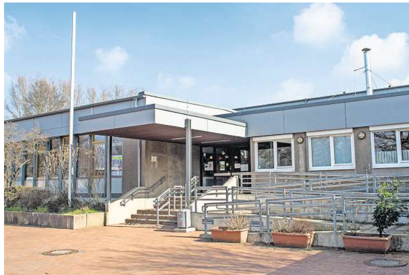
Zieht immer mehr Kinder im Stadtteil an: Die Grundschule Tegelweg im Sahlkamp. FOTO: PHILIPP VON DITFURTH (ARCHIV)
