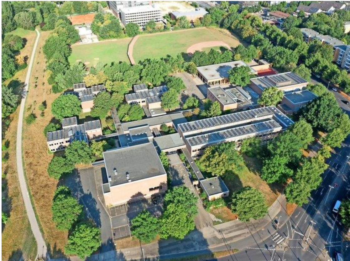
Die Herschelschule soll erweitert werden. Zunächst werden allerdings Container aufgestellt. Foto: privat
